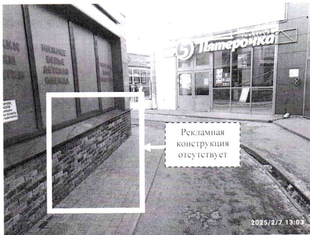
Фото № 2: ул. Гайдара, д. 59г – после проведения работ по демонтажу.
