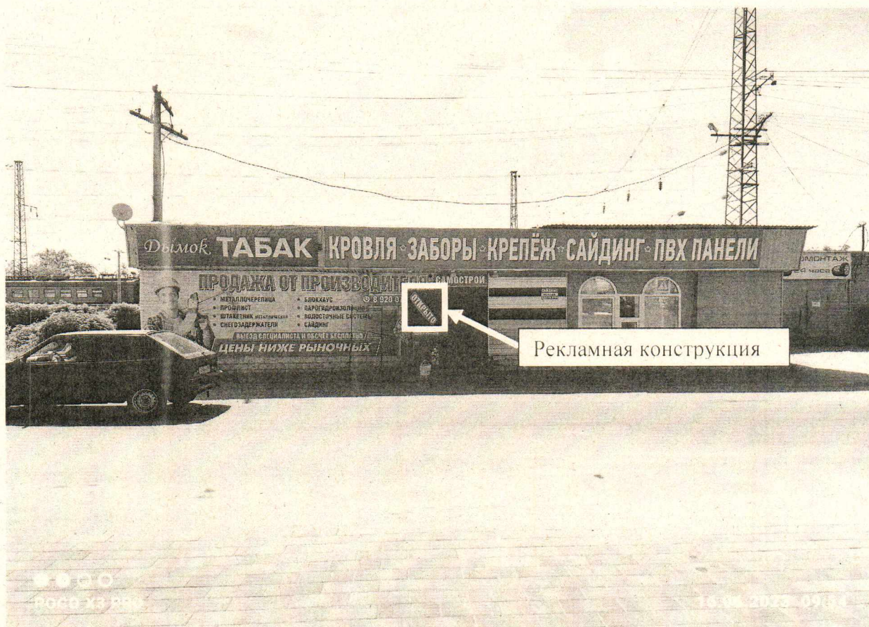
Фото № 1: Панорамный вид размещения рекламной конструкции
