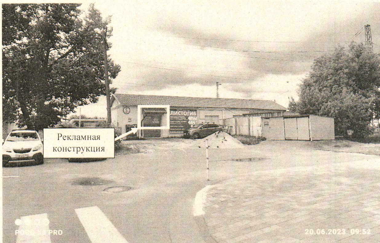
Фото № 1: Панорамный вид размещения рекламной конструкции
