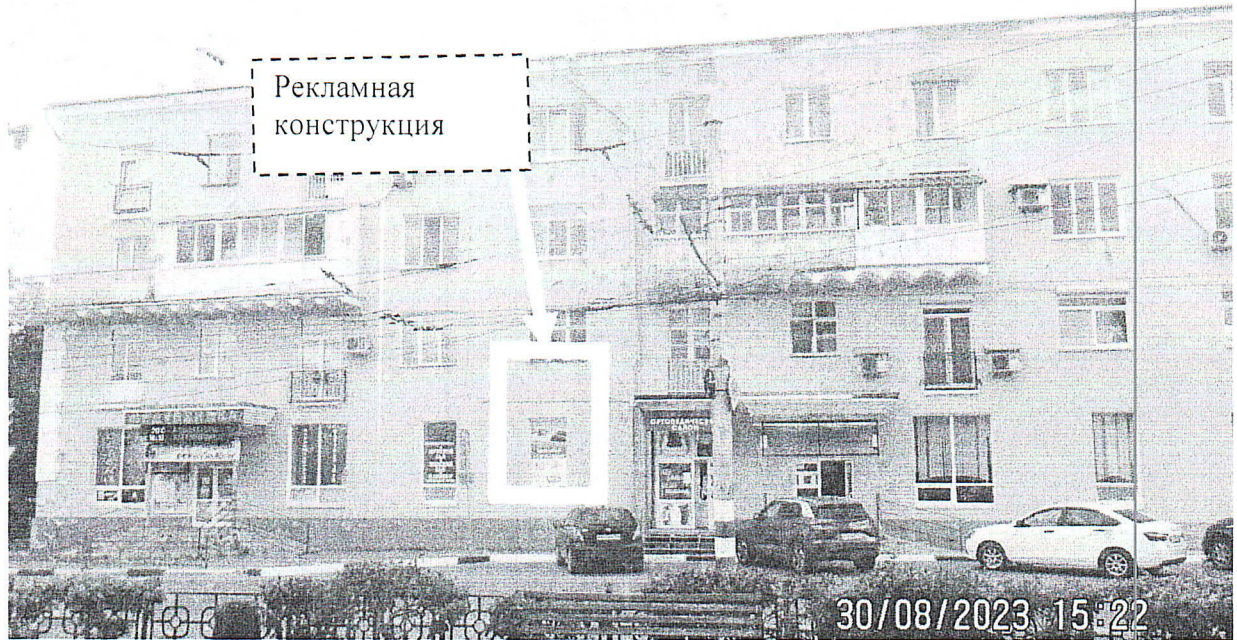
Фото №1: панорамный вид размещения рекламной конструкции
