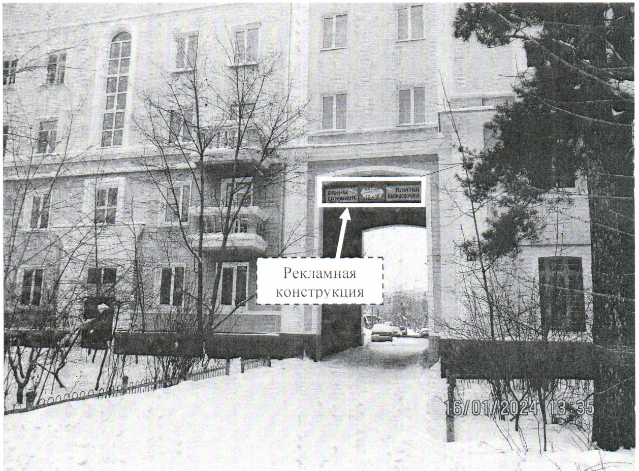
Фото № 1: Панорамный вид размещения рекламной конструкции
