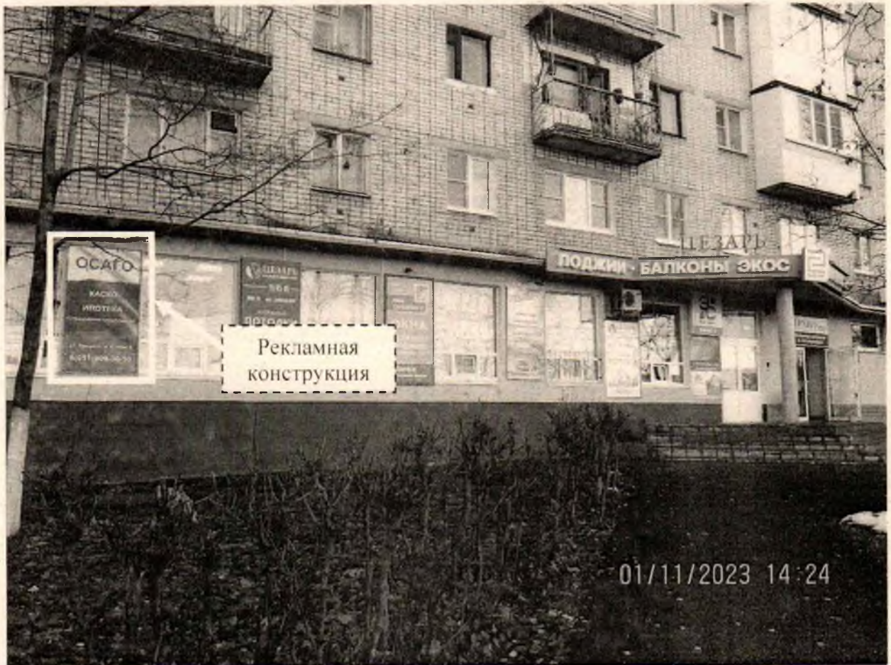
Фото № 1: Панорамный вид размещения рекламной конструкции
