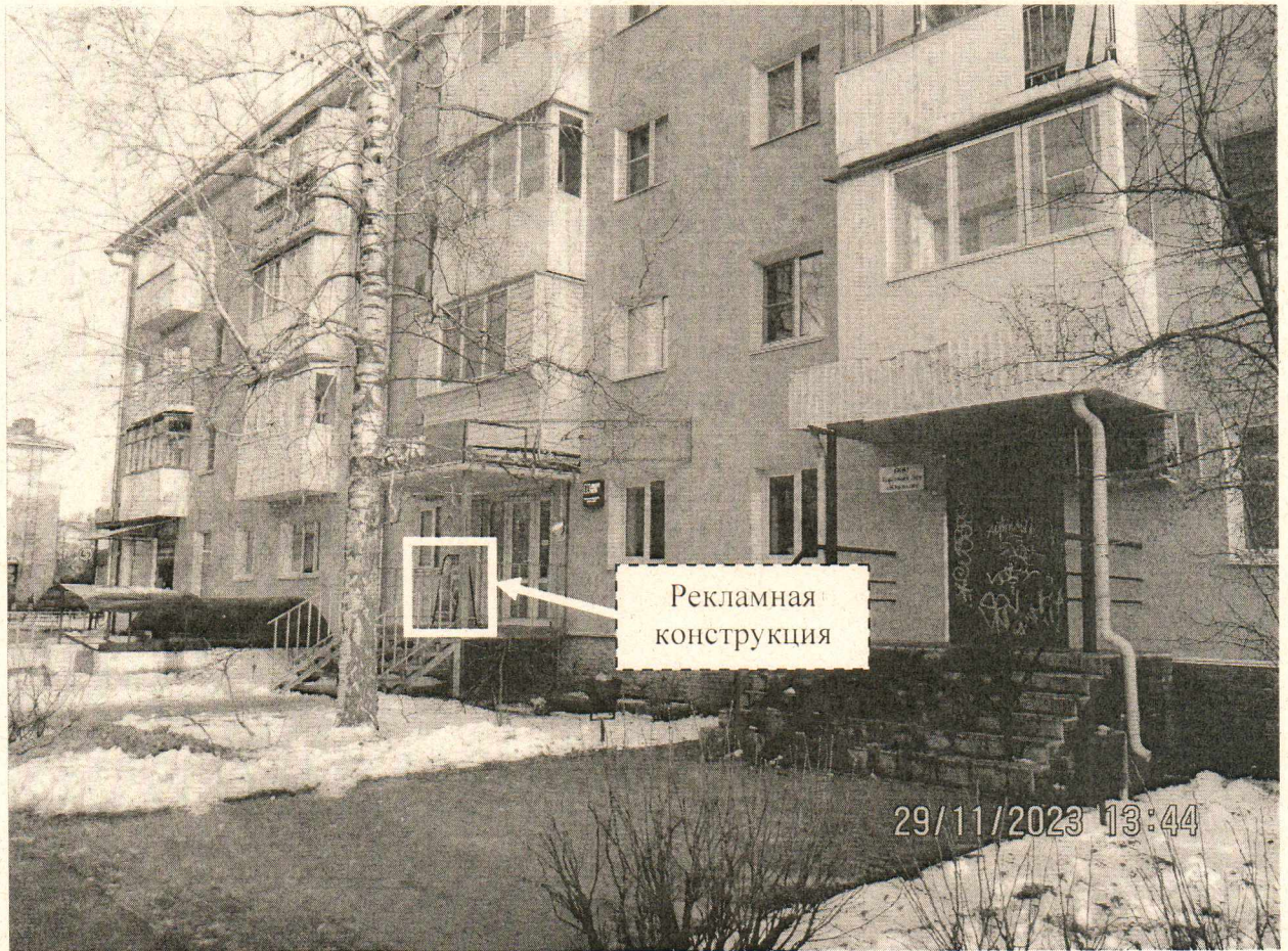
Фото № 1: Панорамный вид размещения рекламной конструкции
