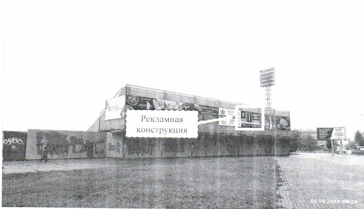
Фото № 1: Панорамный вид размещения рекламной конструкции
