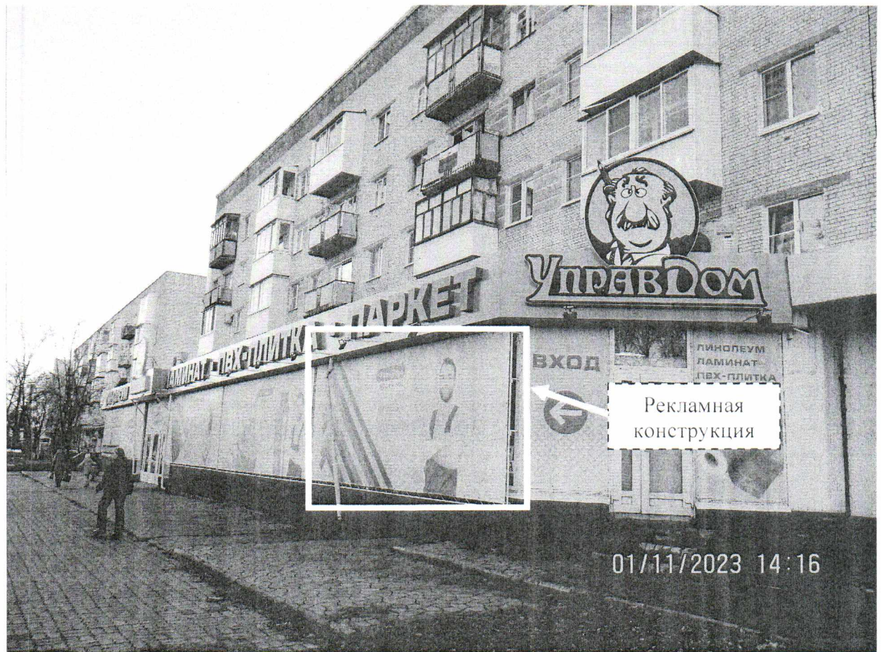
Фото № 1: Панорамный вид размещения рекламной конструкции
