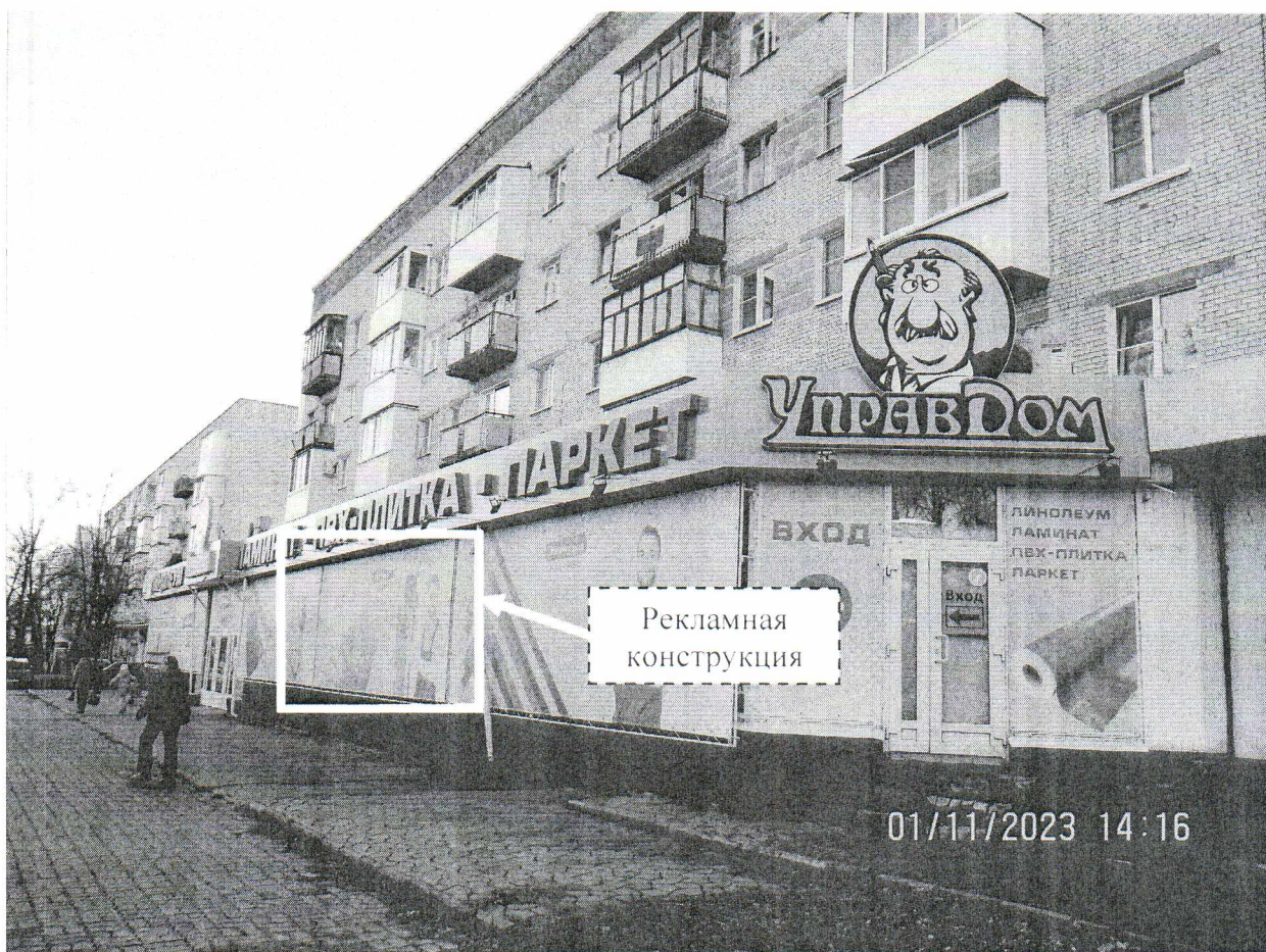
Фото № 1: Панорамный вид размещения рекламной конструкции
