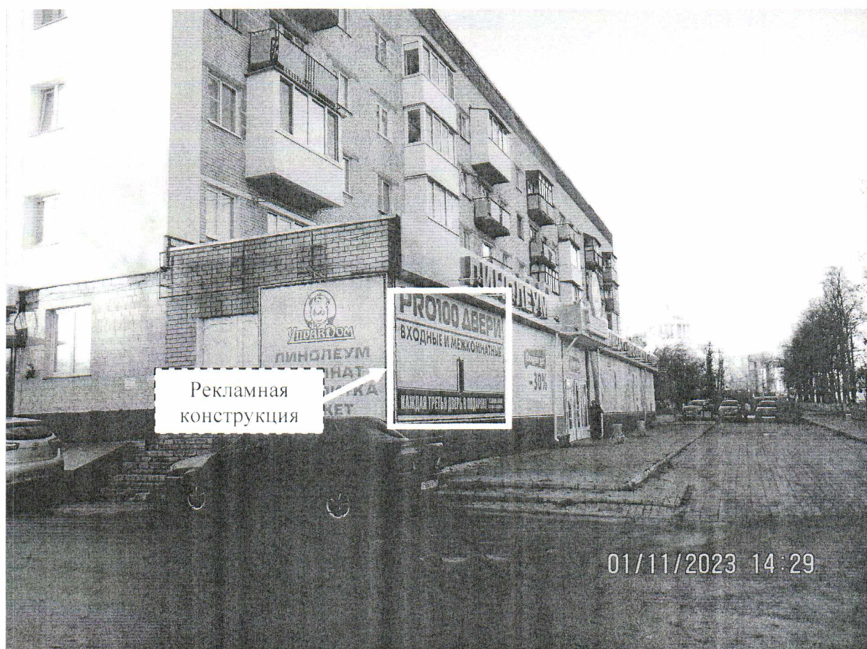
Фото № 1: Панорамный вид размещения рекламной конструкции
