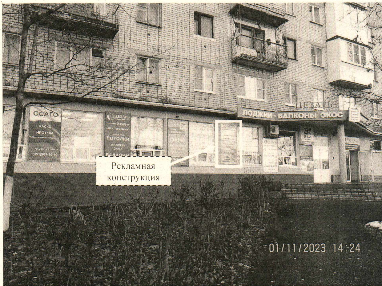
Фото № 1: Панорамный вид размещения рекламной конструкции
