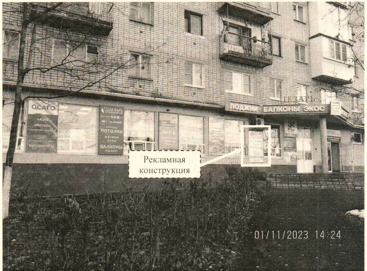
Фото № 1: Панорамный вид размещения рекламной конструкции
