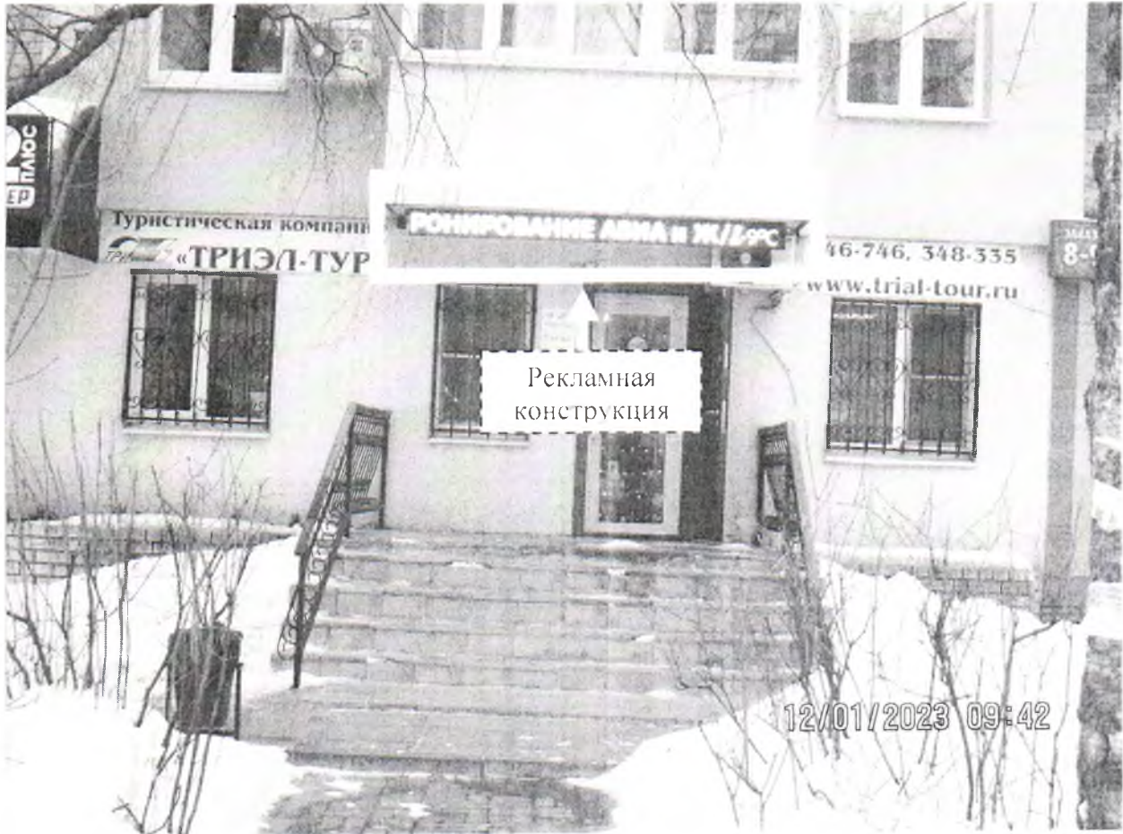
Фото № 1: Панорамный вид размещения рекламной конструкции
