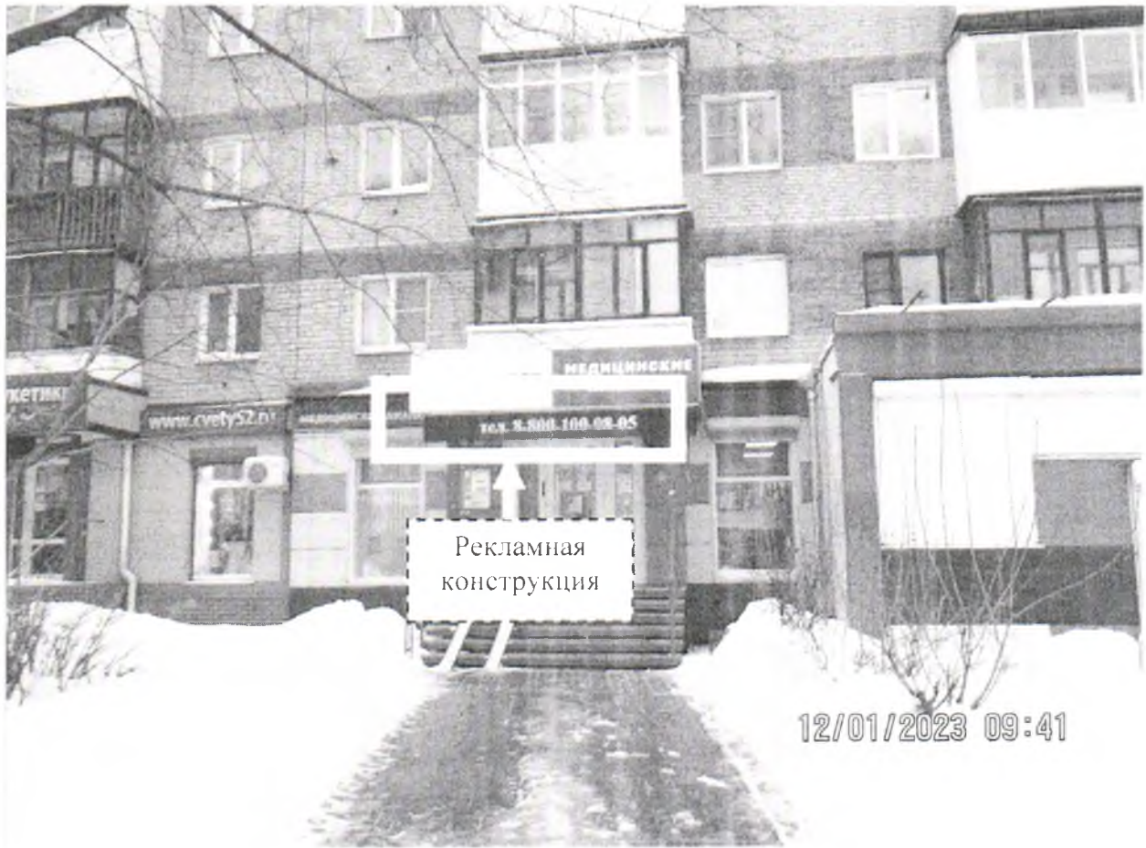
Фото № 1: Панорамный вид размещения рекламной конструкции
