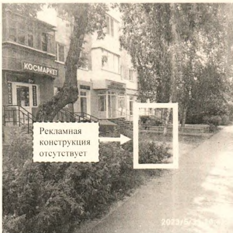
Фото №2: ул. Грибоедова, в районе д. 3 – после проведения работ по демонтажу.
