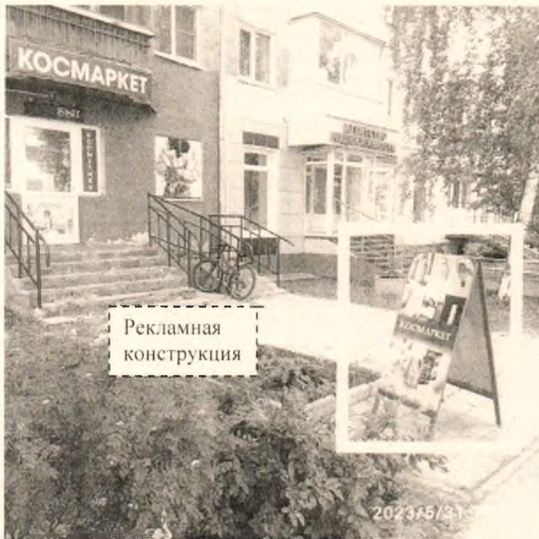
Фото №1: ул. Грибоедова, в районе д. 3 – до проведения работ по демонтажу.
