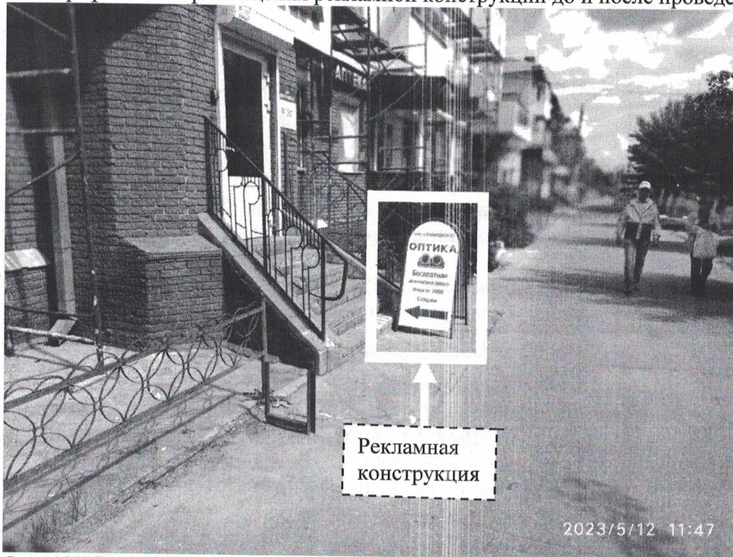
Фото №1: пр.Циолковского в районе д.24 – до проведения работ по демонтажу.
