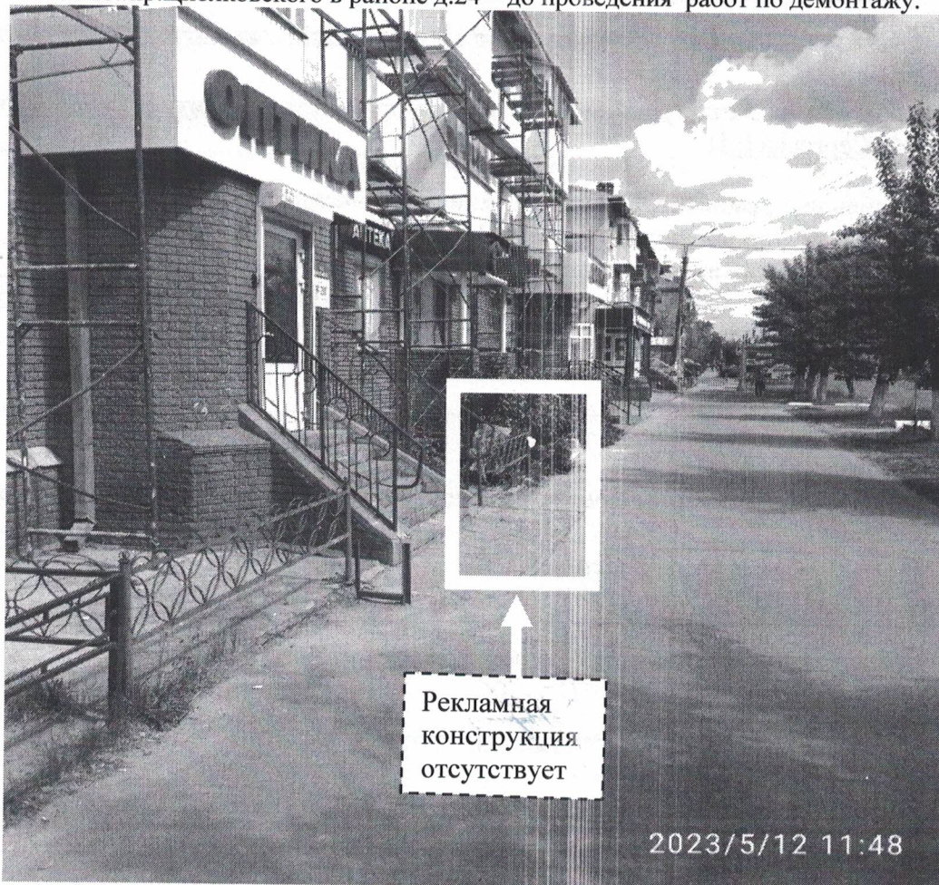
Фото №2: пр.Циолковского в районе д.24 – после проведения работ по демонтажу.
