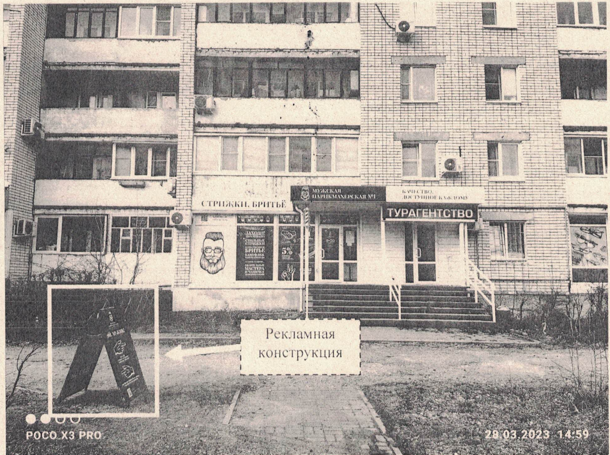
Фото № 1: Панорамный вид размещения рекламной конструкции
