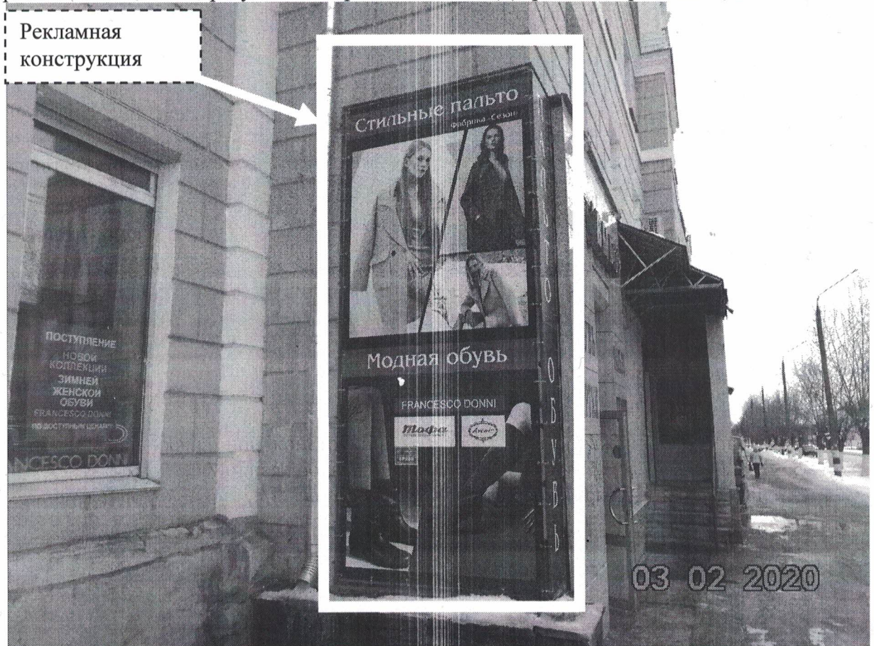
Фото № 1: Панорамный вид размещения рекламной конструкции
