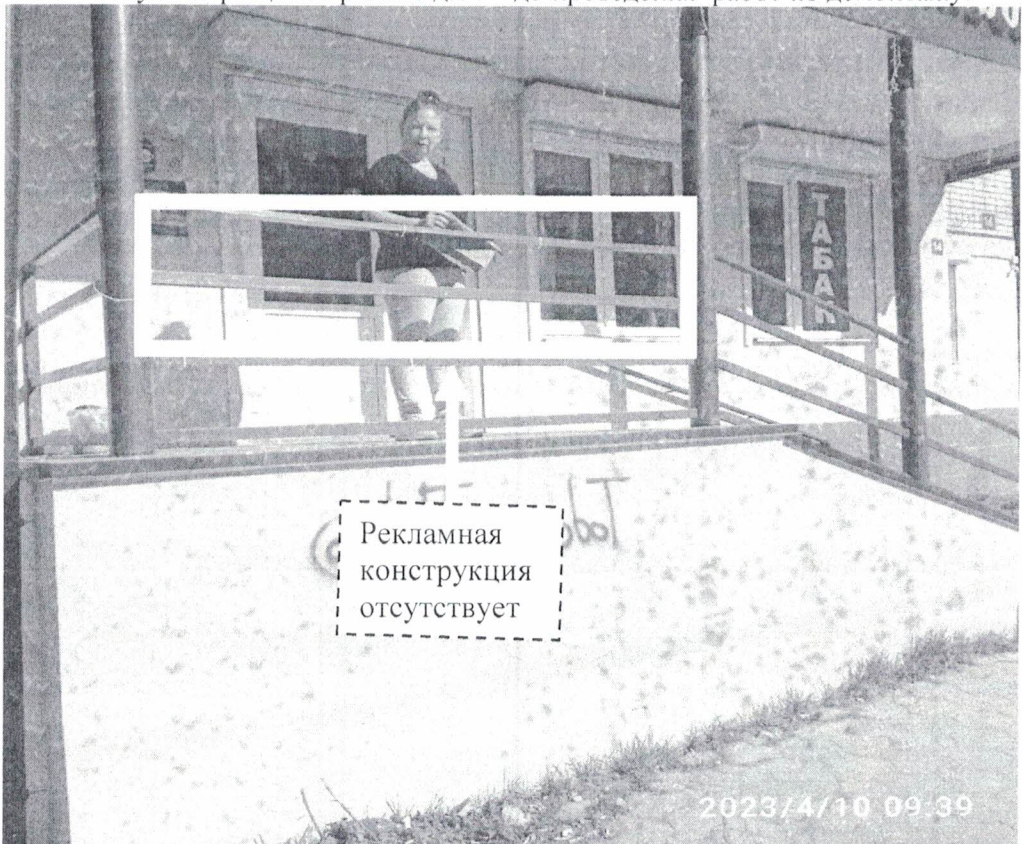
Фото №2: ул.Петрищева в районе д.14 – после проведения работ по демонтажу.
