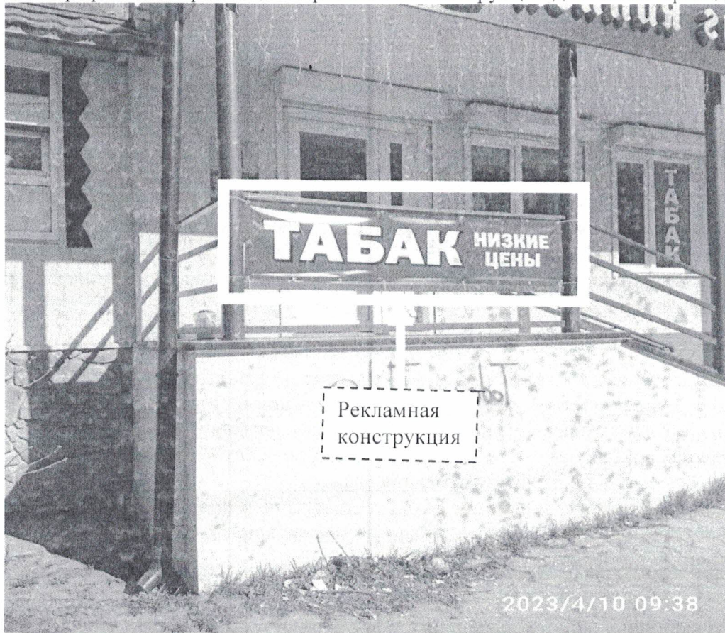
Фото №1: ул.Петрищева в районе д.14 – до проведения работ по демонтажу.
