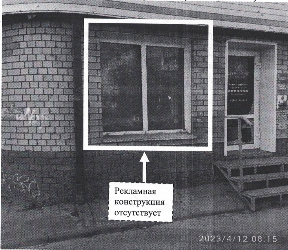
Фото №2: пр.Циолковского д.19 – после проведения работ по демонтажу.
