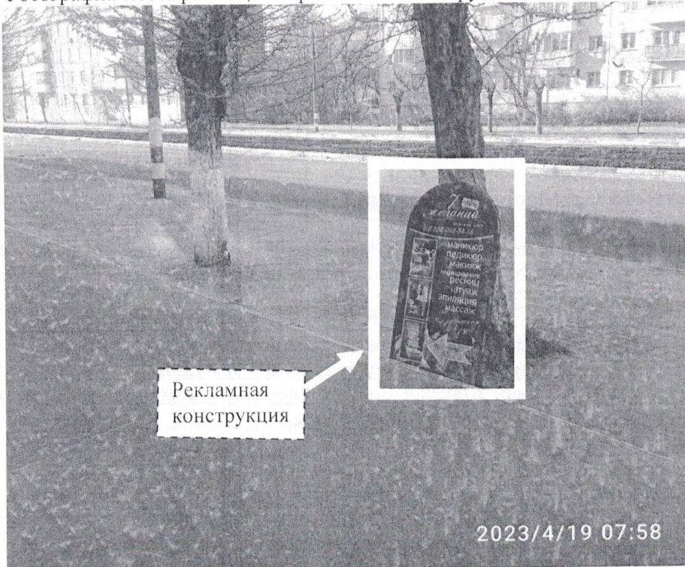
Фото №1: пр.Ленина в районе д.45 – до проведения работ по демонтажу.
