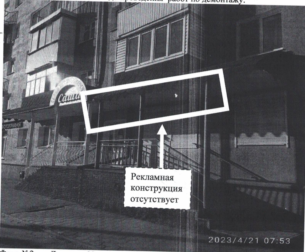
Фото №2: пр.Ленина д.32 – после проведения работ по демонтажу.
