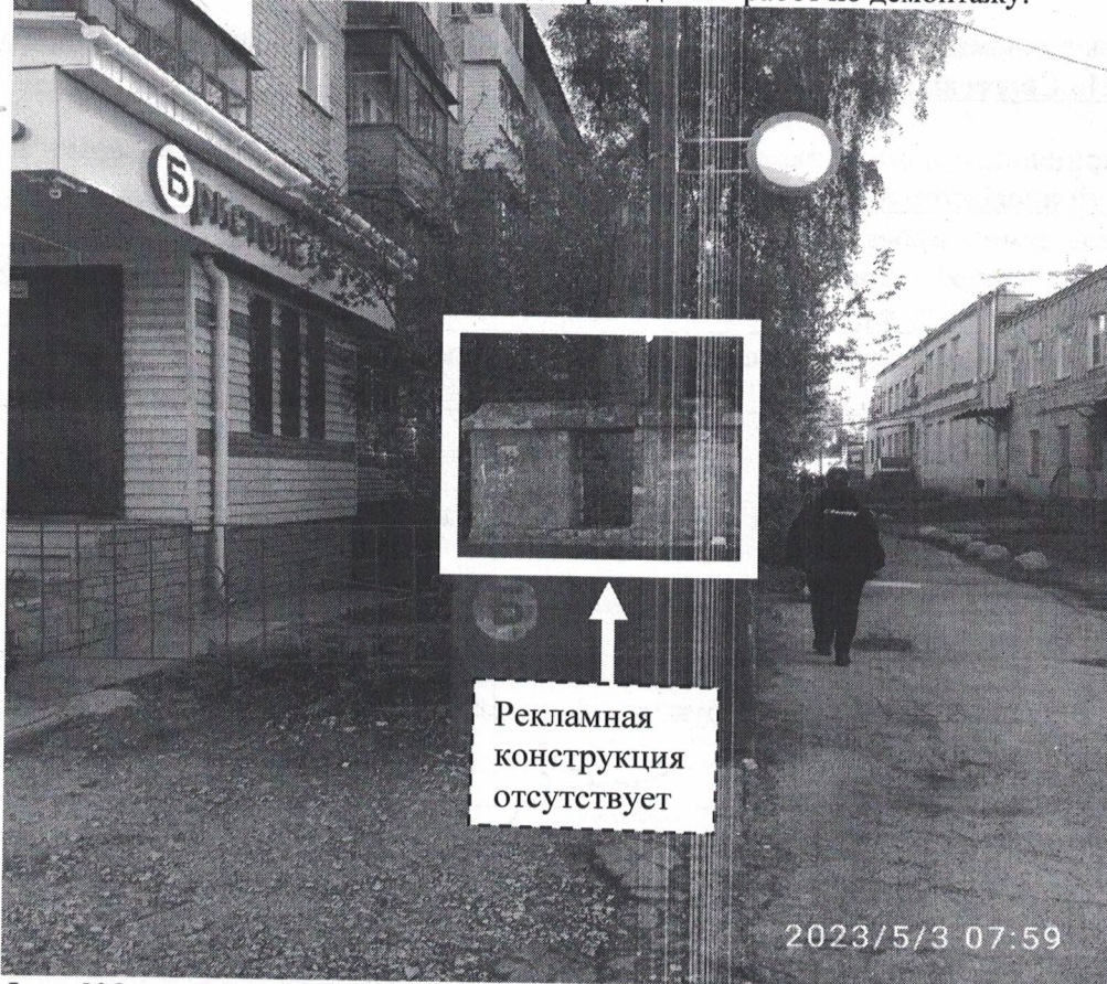
Фото №2: пр.Ленина в районе д.50 – после проведения работ по демонтажу.
