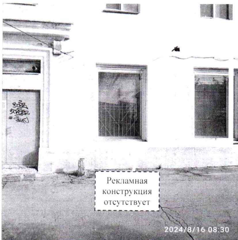
Фото № 2: пр. Ленина, д. 85 – после проведения работ по демонтажу.
