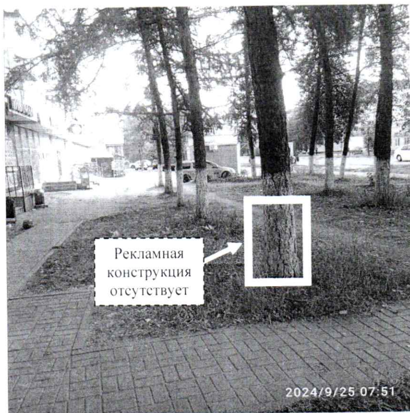
Фото № 2: пр. Чкалова, д. 49 – после проведения работ по демонтажу.
