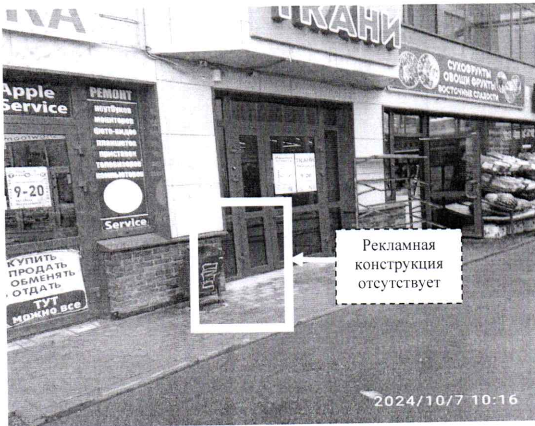
Фото № 2: ул. Гайдара, д. 59Г – после проведения работ по демонтажу.
