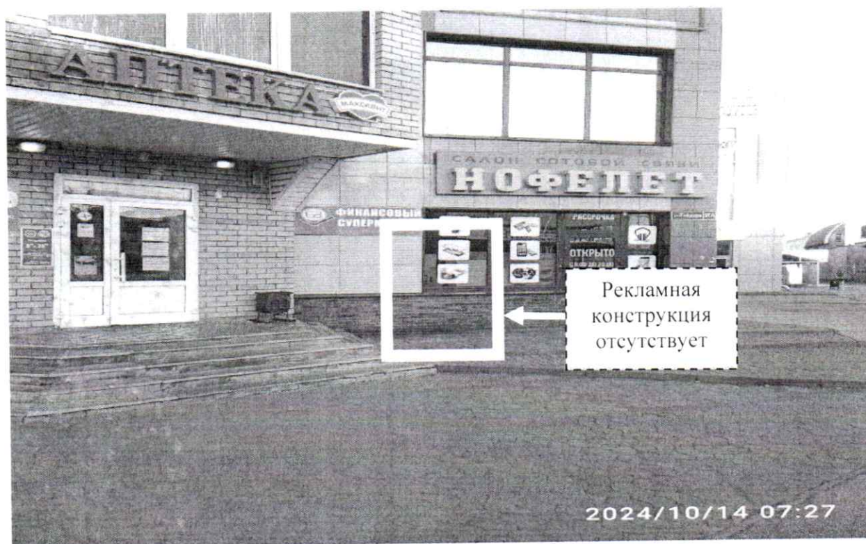
Фото № 2: ул. Гайдара, д. 59Г – после проведения работ по демонтажу.
