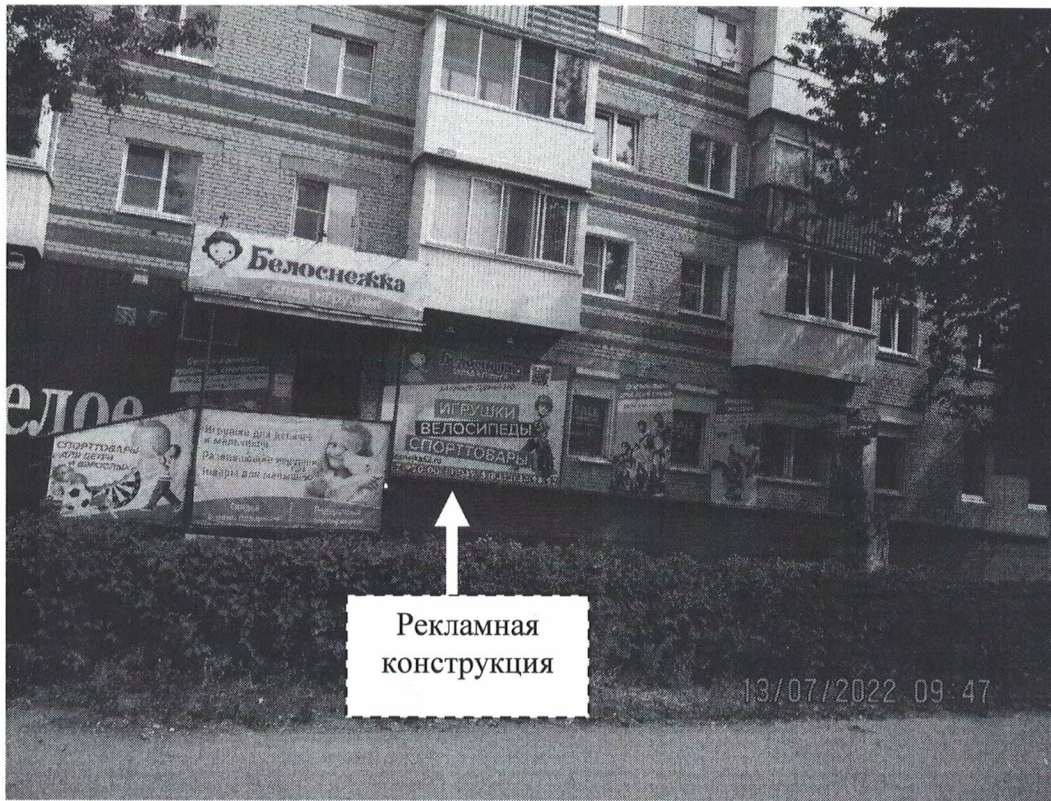
Фото № 1: Панорамный вид размещения рекламной конструкции
