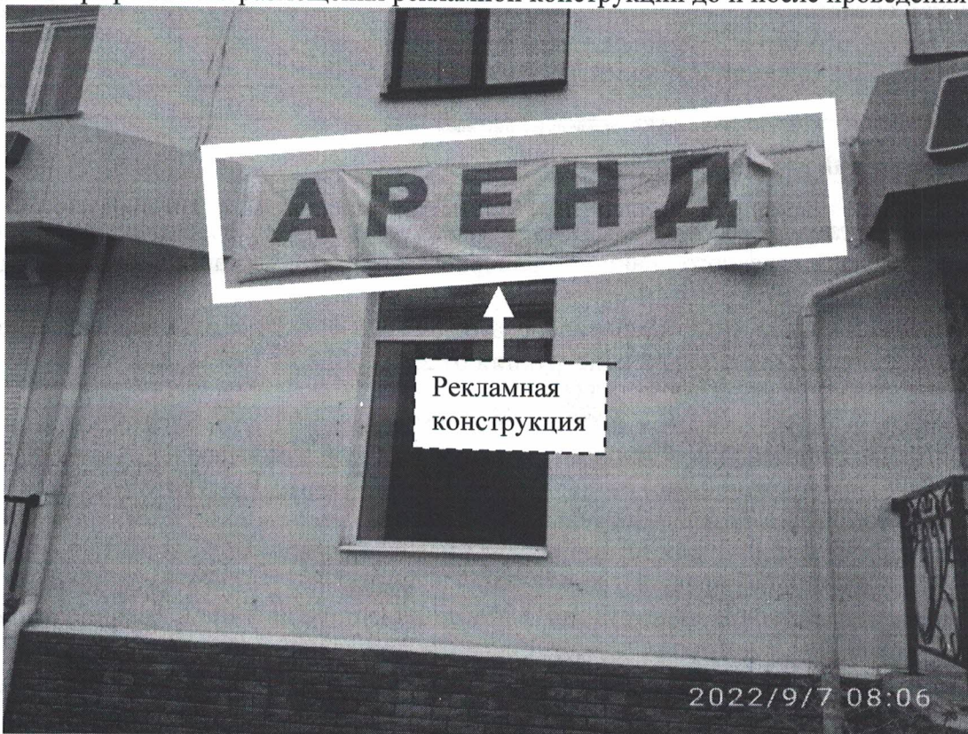
Фото №1: пр.Циолковского д.2 – до проведения работ по демонтажу.
