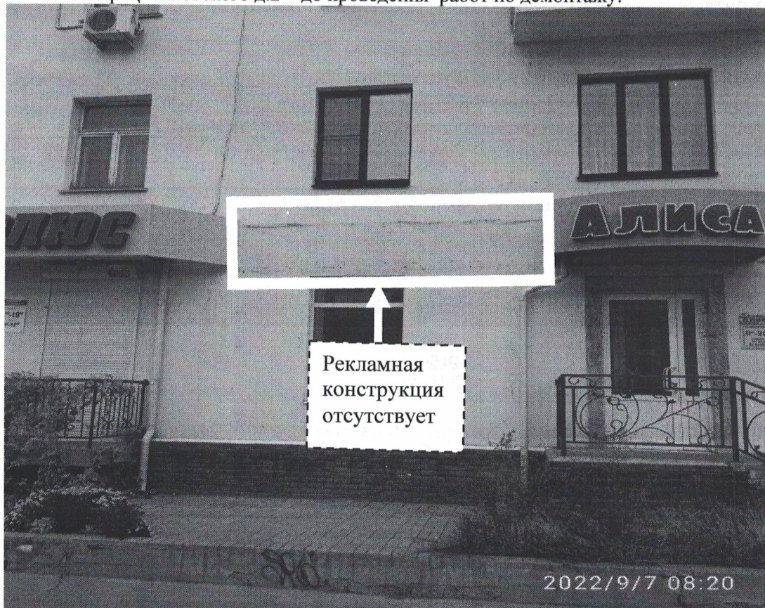
Фото №2: пр.Циолковского д.2 – после проведения работ по демонтажу.
