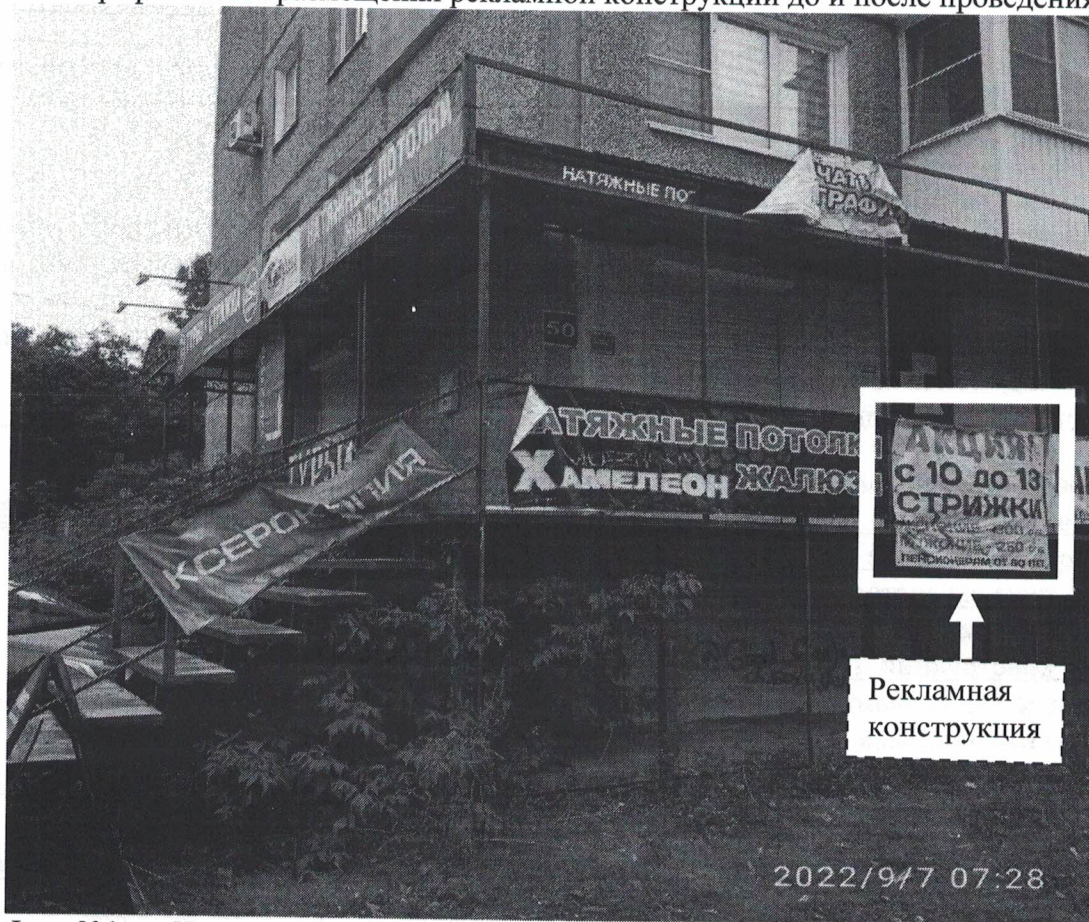
Фото №1: пр.Циолковского д.50 – до проведения работ по демонтажу.
