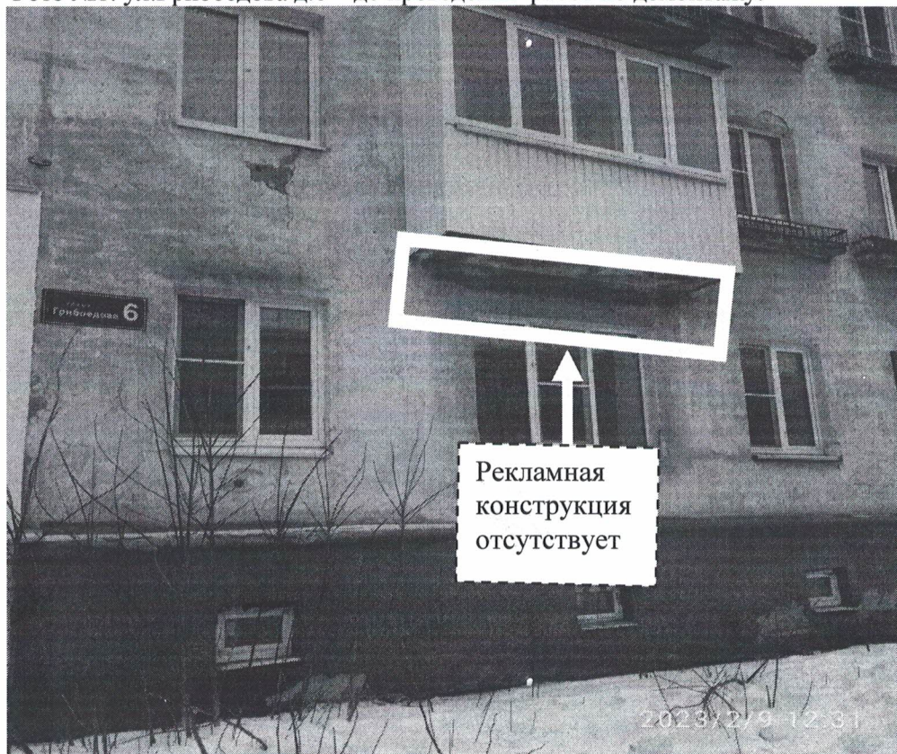
Фото №2: ул.Грибоедова д.6 – после проведения работ по демонтажу.
