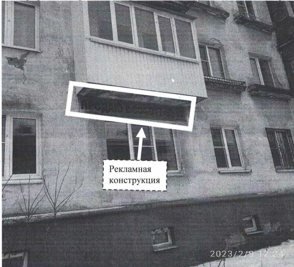
Фото №1: ул.Грибоедова д.6 – до проведения работ по демонтажу.
