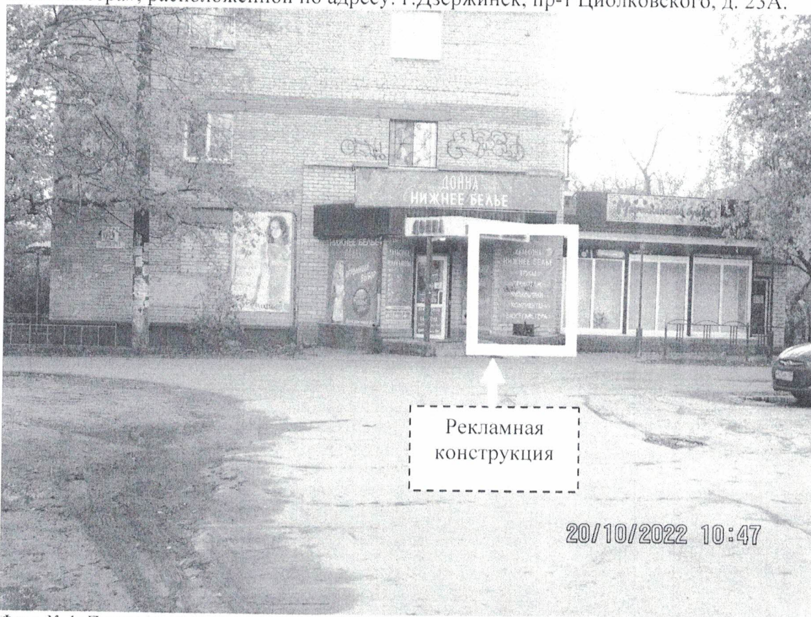
Фото № 1: Панорамный вид размещения рекламной конструкции
