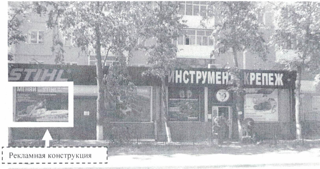
Фото № 1: Панорамный вид размещения рекламной конструкции
