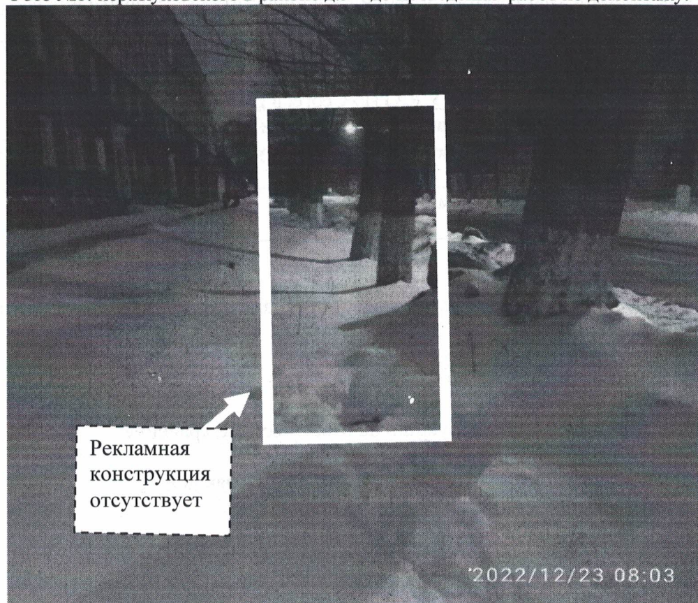
Фото №2: пер. Жуковского в районе д.5 – после проведения работ по демонтажу.
