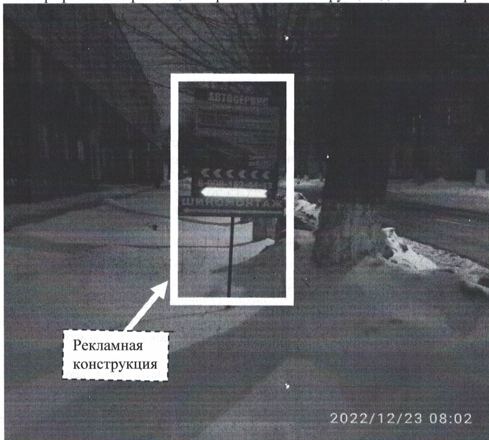
Фото №1: пер. Жуковского в районе д.5 – до проведения работ по демонтажу.
