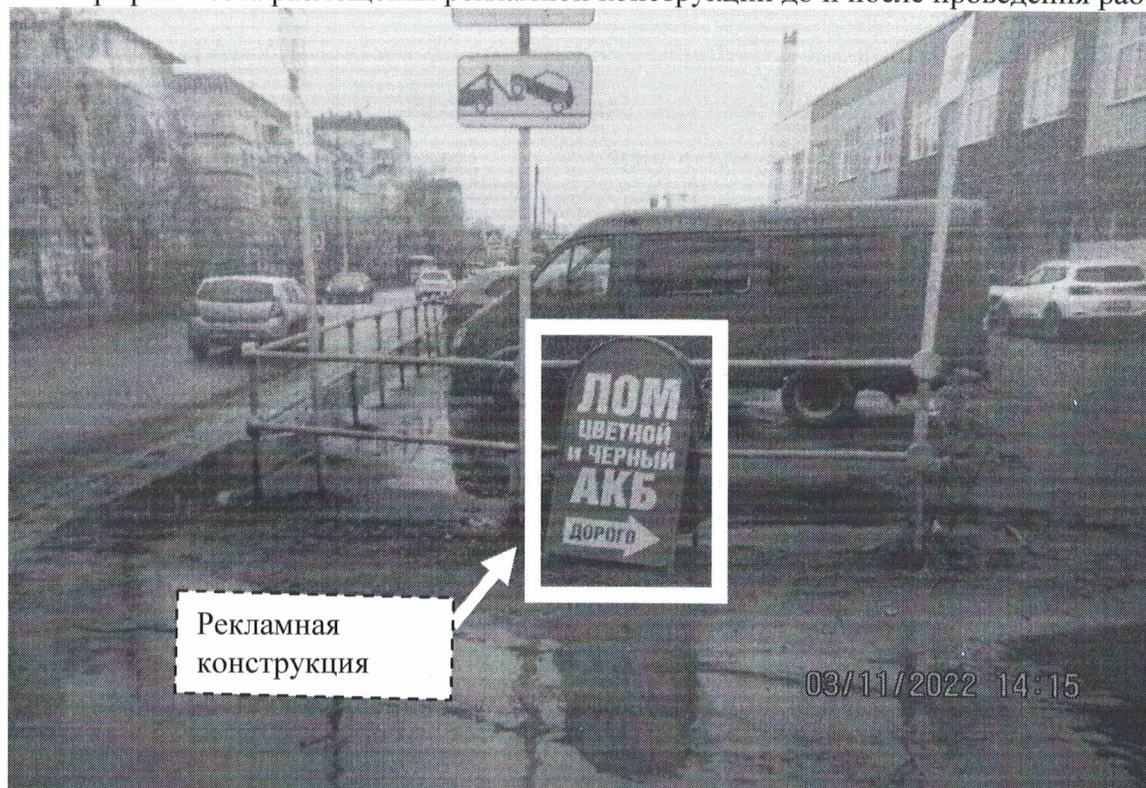
Фото №1: ул. Новомосковская в районе д.21 до проведения работ по демонтажу.
