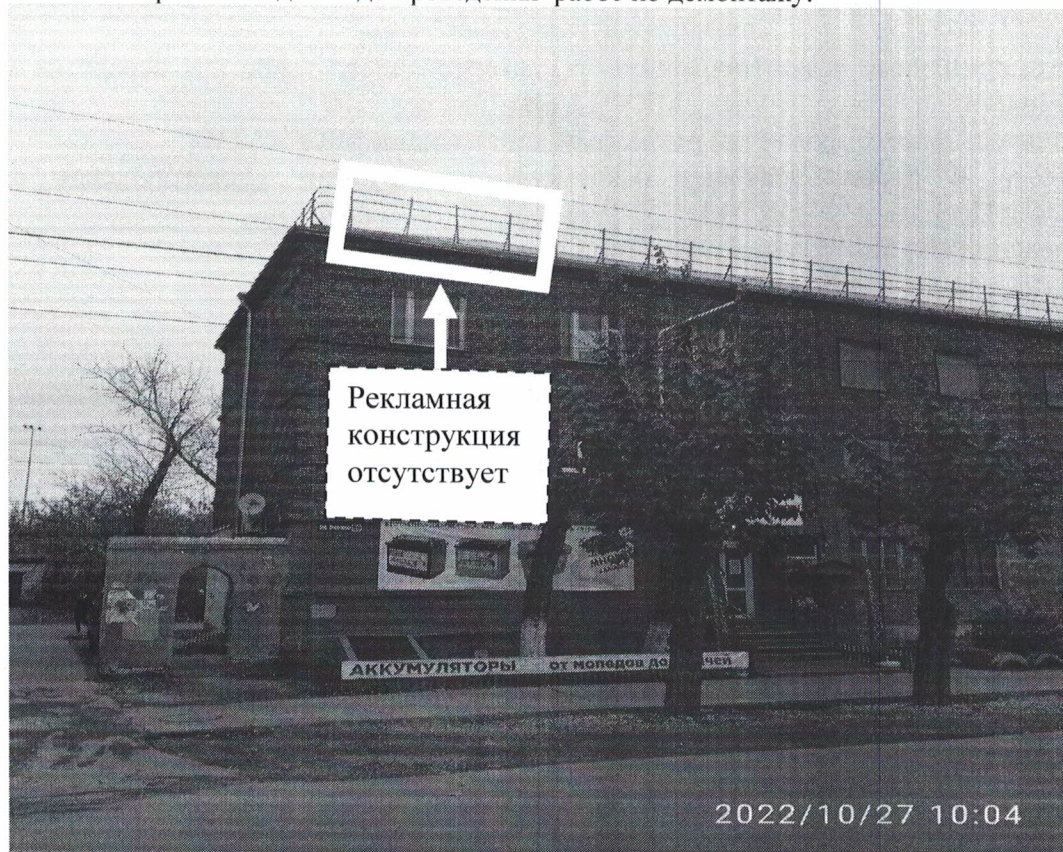
Фото №2: пр.Ленина д.99 – после проведения работ по демонтажу.
