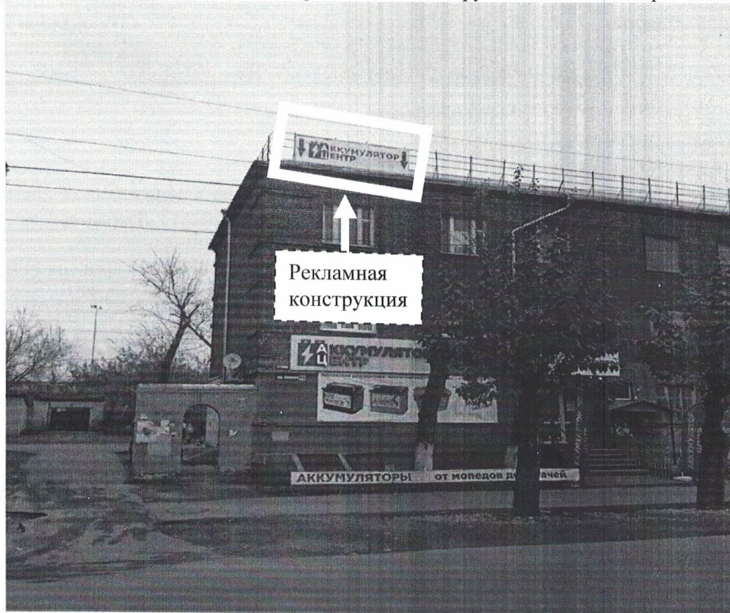
Фото №1: пр.Ленина д.99 – до проведения работ по демонтажу.
