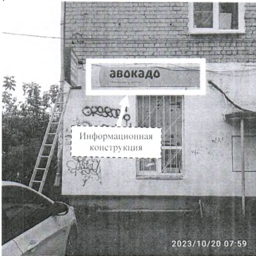
Фото №1: пр. Циолковского д. 20 – до проведения работ по демонтажу.
