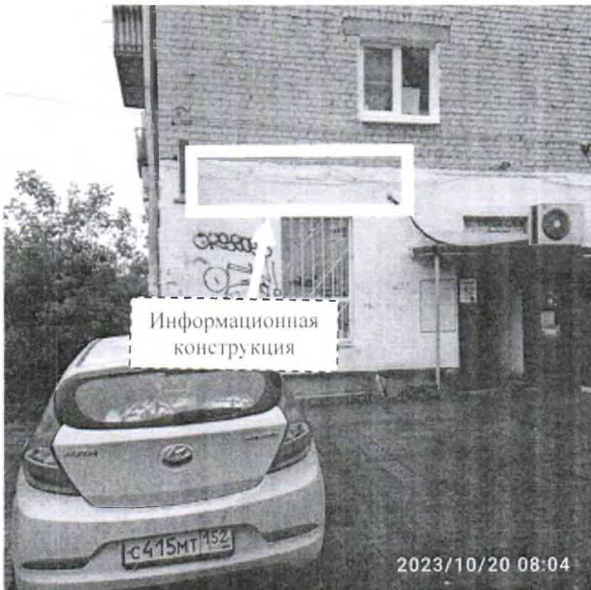
Фото №2: пр. Циолковского д. 20 – после проведения работ по демонтажу.
