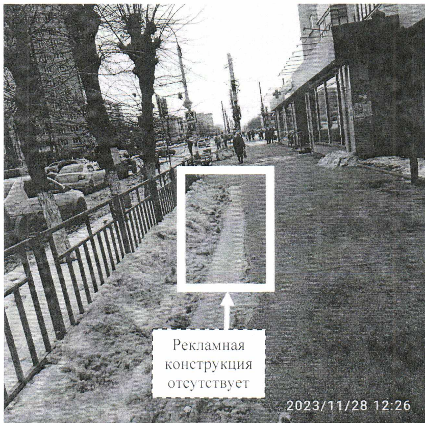
Фото № 2: пр. Циолковского, д. 30 – после проведения работ по демонтажу.
