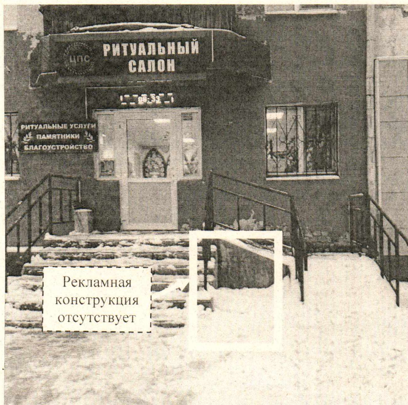
Фото № 2: ул. Грибоедова, д. 3 – после проведения работ по демонтажу.
