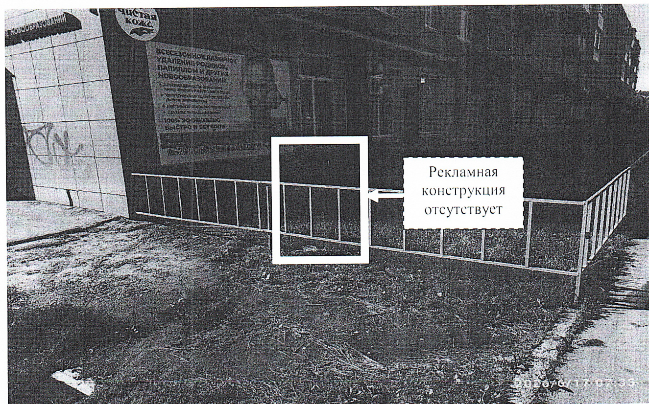
Фото № 2: ул. Гайдара, 30 – после проведения работ по демонтажу.
