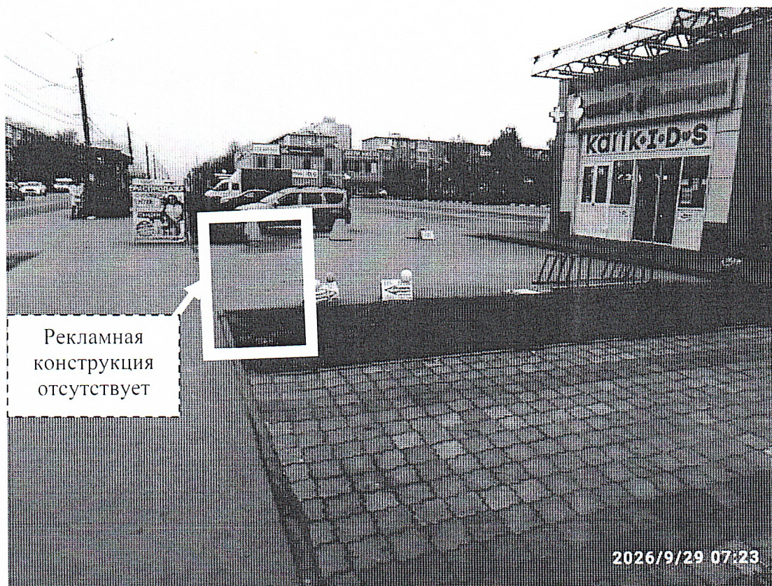
Фото № 2: ул. Гайдара, в районе д. 61 – после проведения работ по демонтажу.
