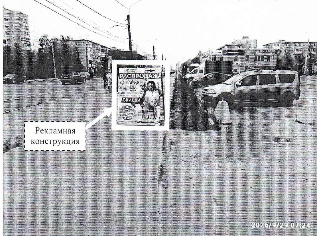
Фото № 1: ул. Гайдара, в районе д. 61 – до проведения работ по демонтажу.
