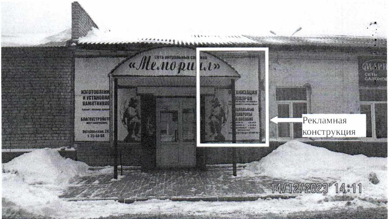
Фото № 1: Панорамный вид размещения рекламной конструкции
