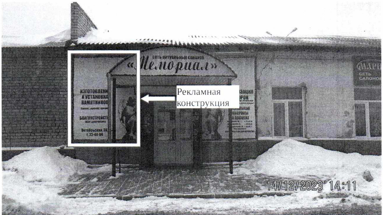
Фото № 1: Панорамный вид размещения рекламной конструкции
