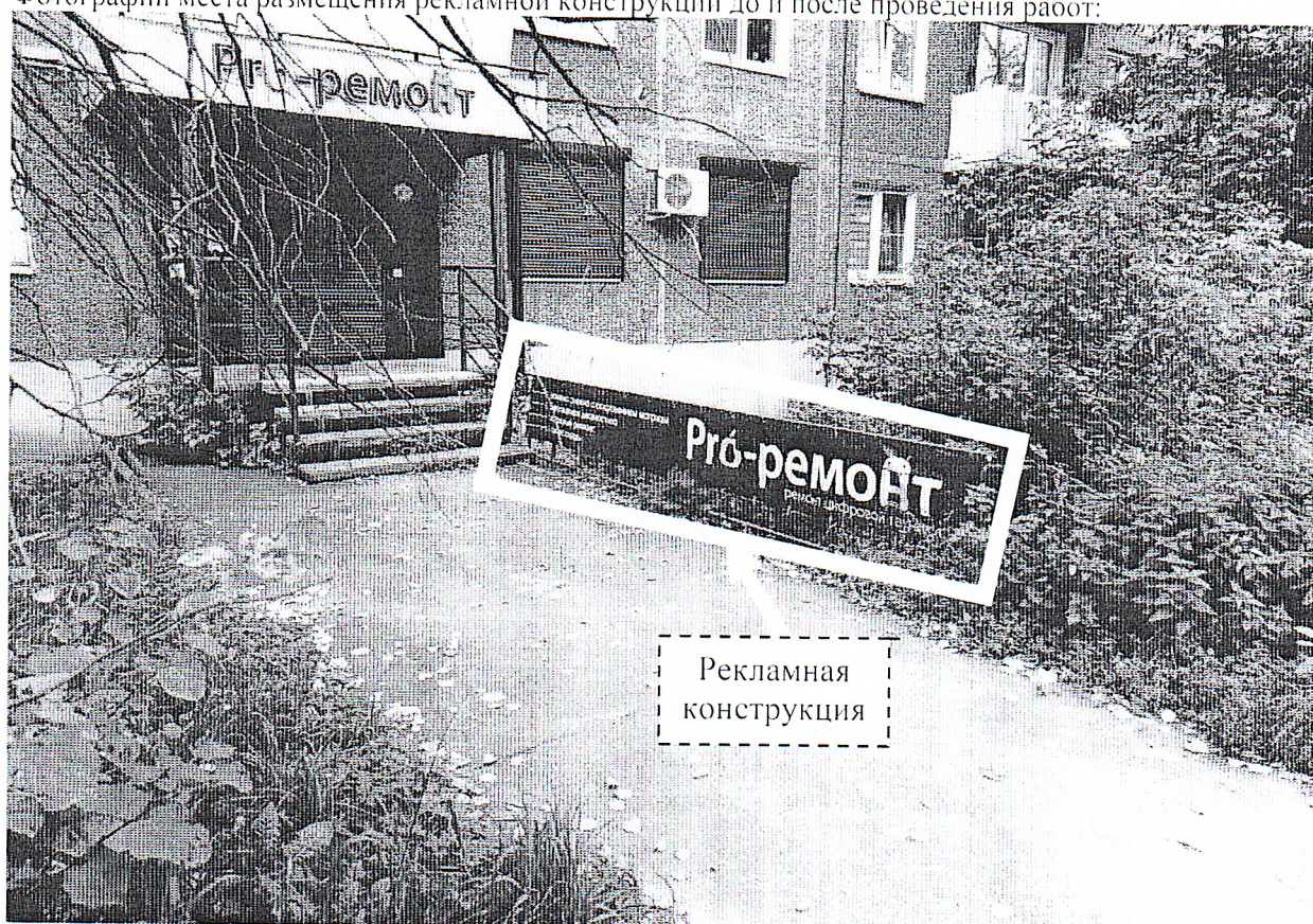
Фото № 1: ул. Петрищева, д. 3 – до проведения работ по демонтажу.
