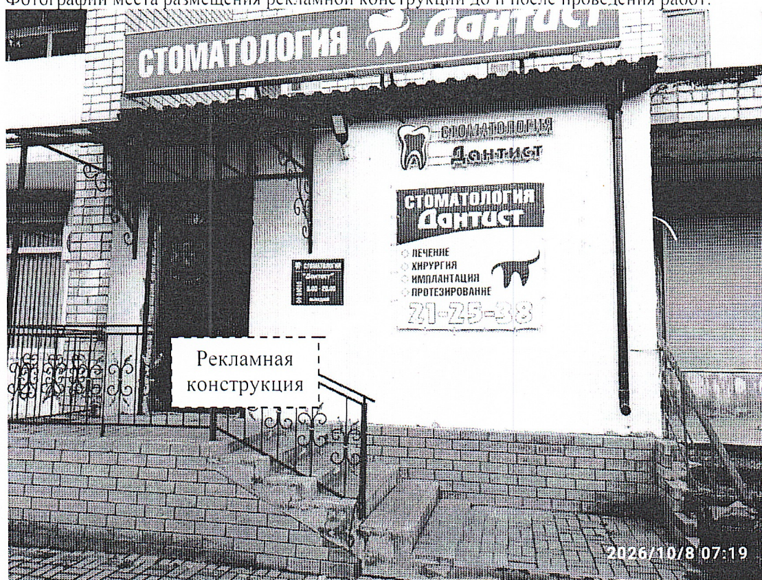
Фото № 1: пр. Чкалова, д. 29 – до проведения работ по демонтажу.
