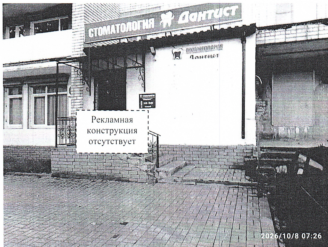
Фото № 2: пр. Чкалова, д. 29 – после проведения работ по демонтажу.
