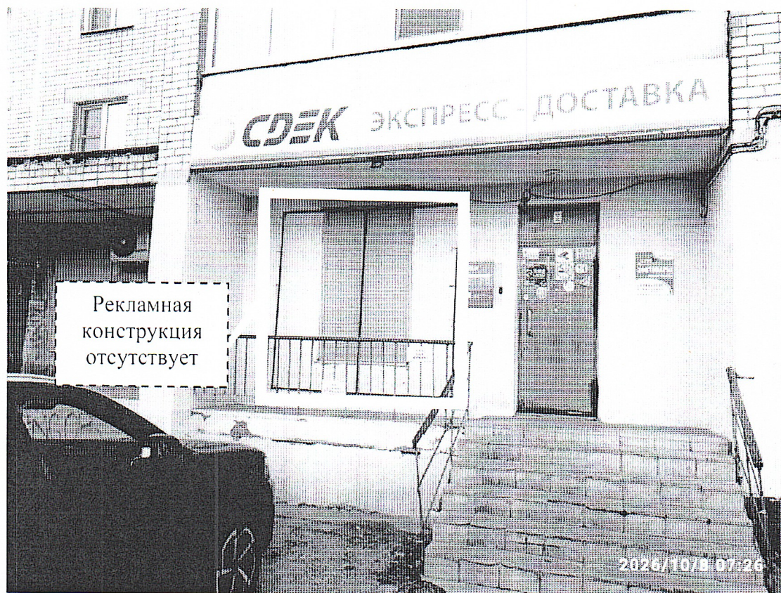
Фото № 2: пр. Чкалова, д. 29 – после проведения работ по демонтажу.
