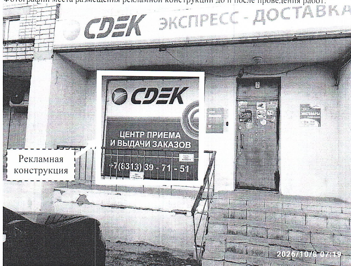
Фото № 1: пр. Чкалова, д. 29 – до проведения работ по демонтажу.
