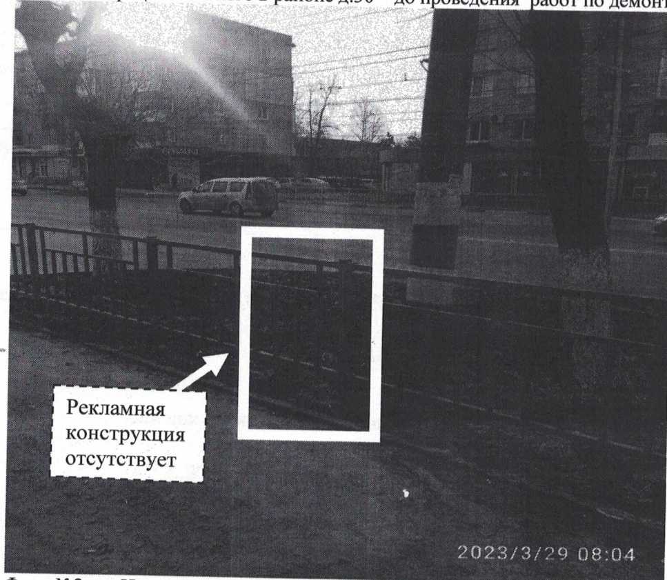
Фото №2: пр.Циолковского в районе д.30 – после проведения работ по демонтажу.
