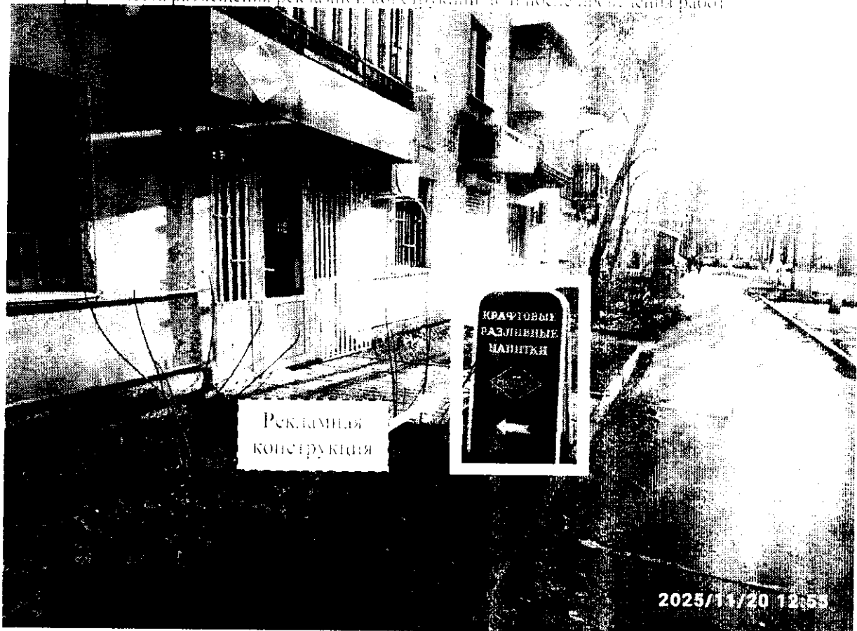
Фото № 1: ул. Грибоедова, д. 19 — до проведения работ по демонтажу
